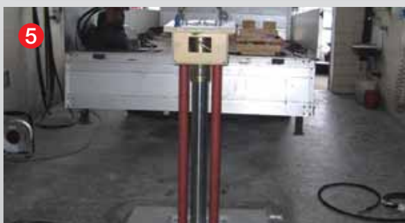
5 Die neue Hebebühne wird montiert
