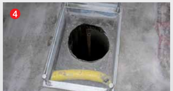
4 Bereit für die Montage der neuen Hebebühne
